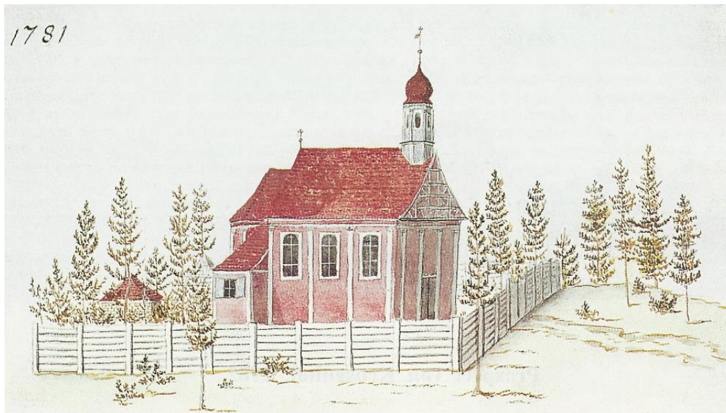
20. attēls. Katlakalna vecā baznīca Akmeņsalā, 1781. gadā
